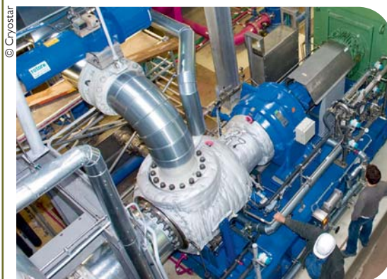
Geothermy Unterhaching GmbH & Co KG 3.7 MW Cryostar turbo generator.
